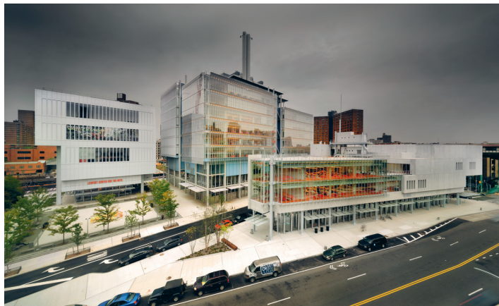
[18] Trzy pierwsze budynki oddane do użytku, z lewej strony The Lenfest Center for the Arts, w środku The Jerome L. Greene Science Center oraz z prawej The Forum
